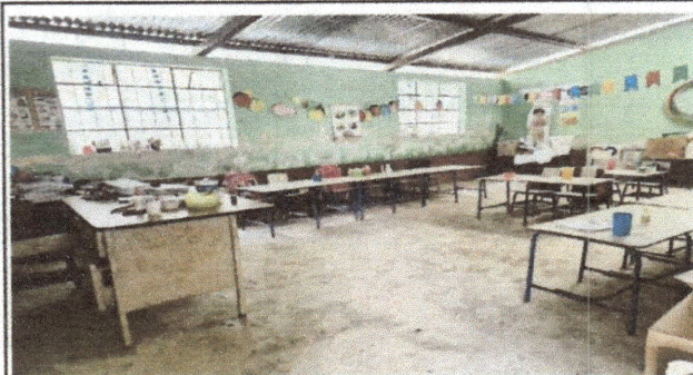
Foto 8: Piso de aula 2 en mal estado (modulo 1)
