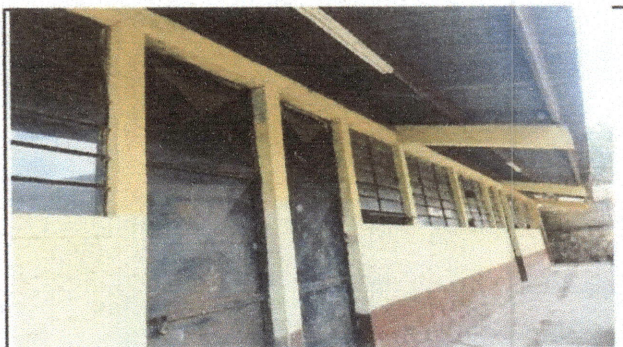
Foto 4: Mantenimiento (pintura) a puertas
